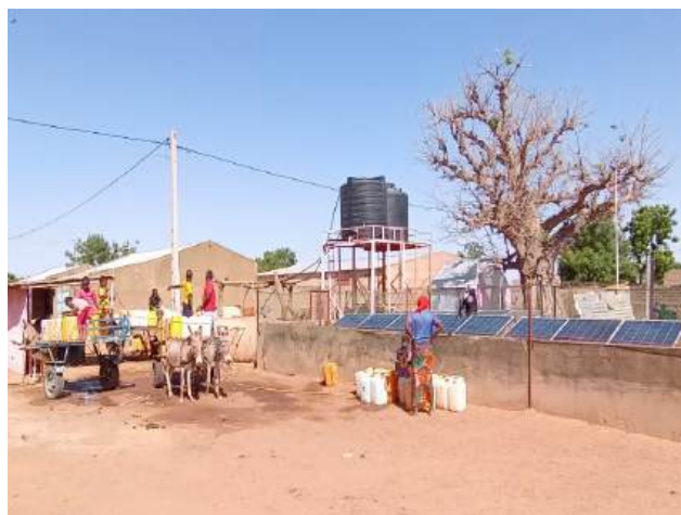
Photo 9&10 : Puits équipés de pompe solaire à Mbéné Mamour et Daga Balla
