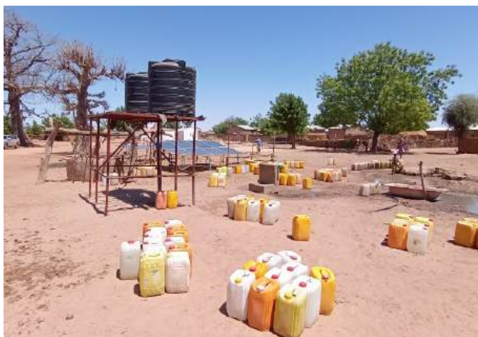
Photo 9&10 : Puits équipés de pompe solaire à Mbéné Mamour et Daga Balla
