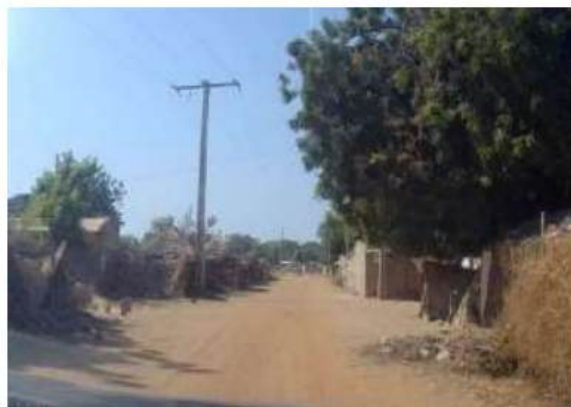
PK 2+700 : Poteau MT à déplacer
