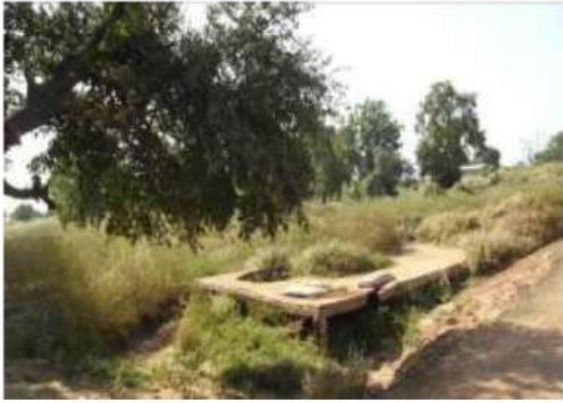
PK 2+350 : Ouvrage à l'entrée de Kounghoul Socé
