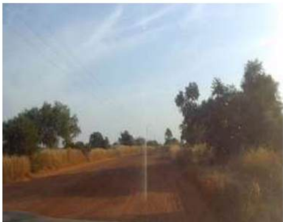
PK 4+000 : Long alignement droit
