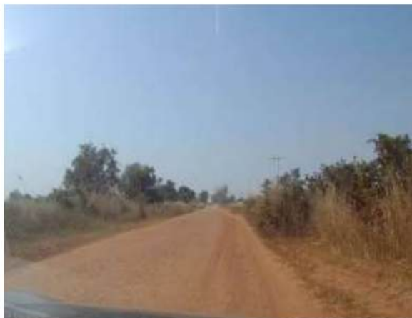
PK 4+800 : Emprise assez large
