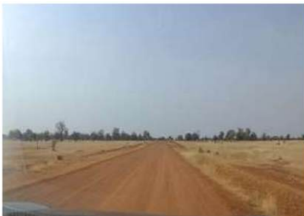
PK 138 : Bon état de surface de roulement
