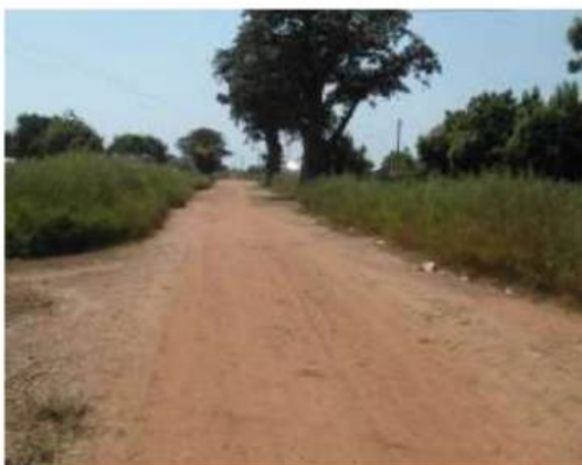
PK 25+700 : Long alignement droit (entrée Maka Gouye)
