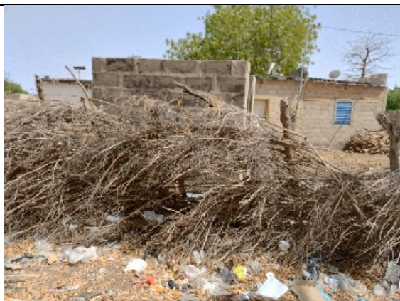
Photo 8 : Vue d'une clôture en haie morte et d'une toilette en dur affectées au sein d'une structure d'habitation dans l'emprise de la route nationale au niveau de la commune de Thiel
