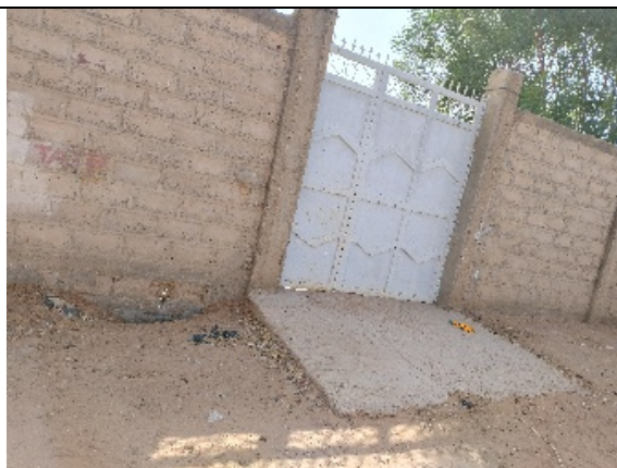
Photo 5 : Vue d'une excroissance (dallage) affectée à usage d'habitation dans l'emprise de la piste Taïf - Sam Fall au niveau de la commune de Taïf
