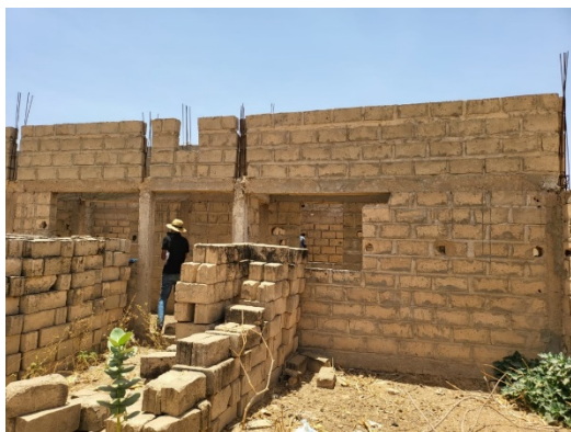
Photo 6 : Vue d'une structure d'habitation en construction affectée dans l'emprise de la route nationale au niveau de la commune de Sadio
