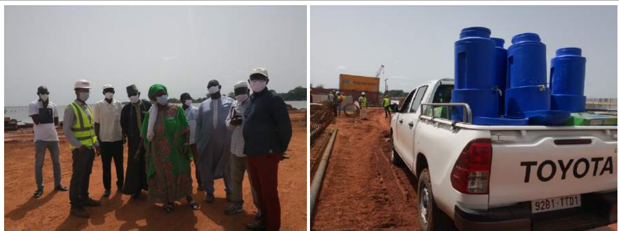
Photo 6&7 : Don de dispositif de lavage des mains aux communes concernées par les travaux du pont de Marsassoum par l'entreprise MATIERE
