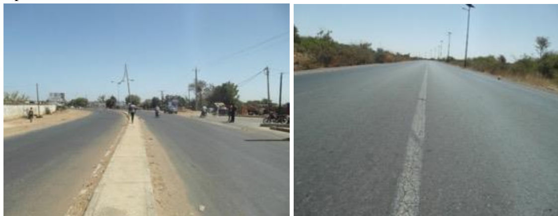
Photo 1&2 : La voie de contournement de Thiès (chaussée relativement en bon état)
