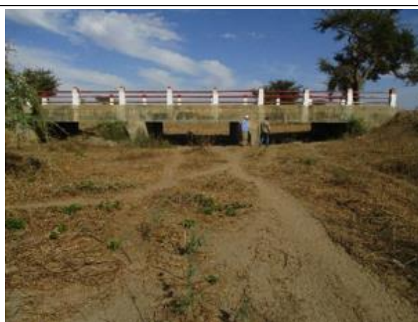
Photo 3 : Chaussée très dégradée (faïençage -PK 21+000) Photo 4 : Pont à poutres en béton armé (PK 12+314)
