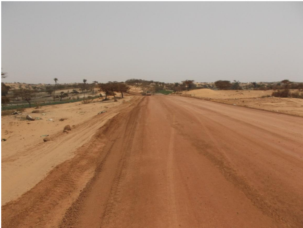
Photo de la route en construction
